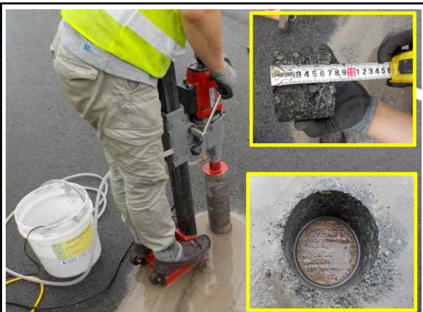
사진설명 교면포장 방수층확인(코어채취)
