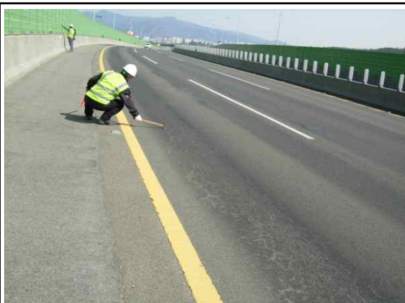
사진설명 교면포장 외관조사 현황
